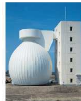
久留米市南部浄化センター
